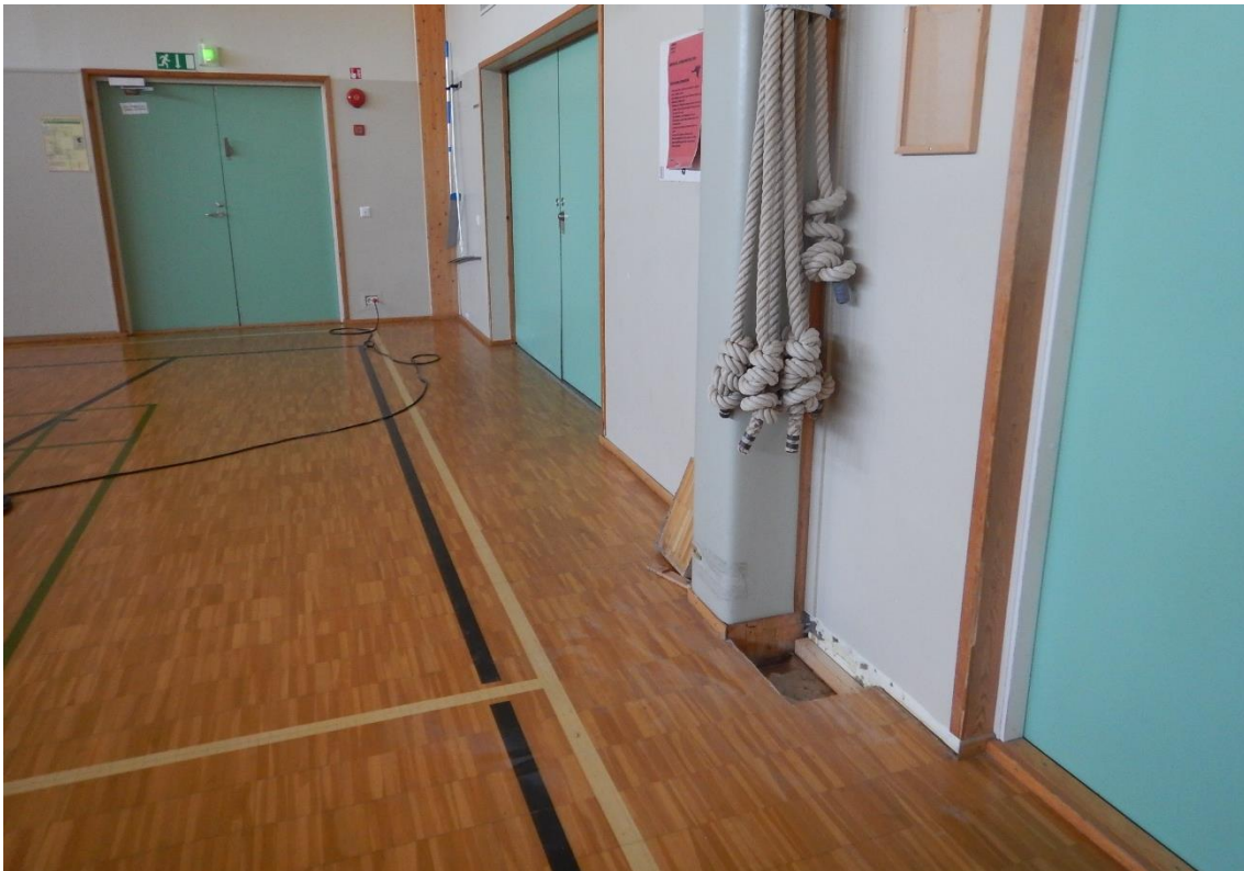
Kuva 28. Liikuntasalin lattian rakenneavaus A1
