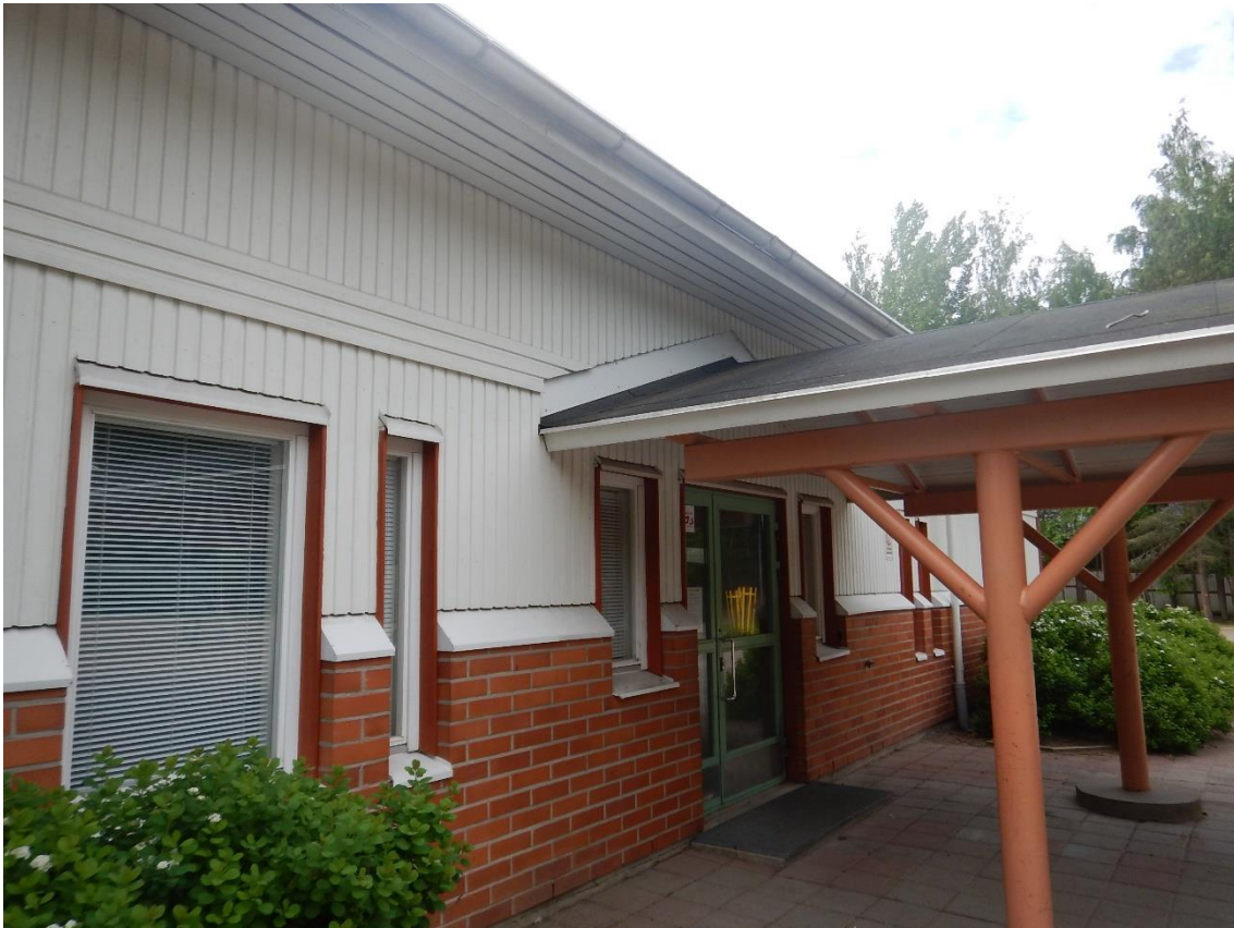
Kuva 65. Sisäänkäynnin katos hyväkuntoinen.
