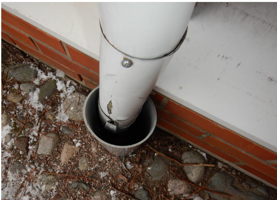
Kuva 7. Sadevesijärjestelmä vaikuttaa toimivalta rännivesien osalta.
