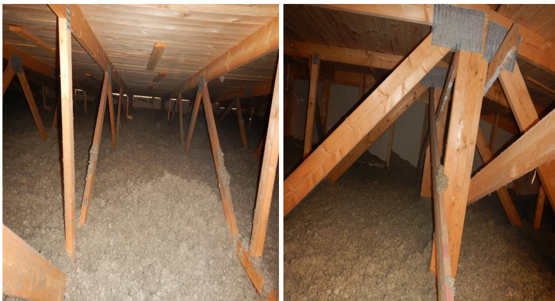
Kuva 73. Yläpohjan rakenteet olivat aistinvaraisesti hyvässä kunnossa.
