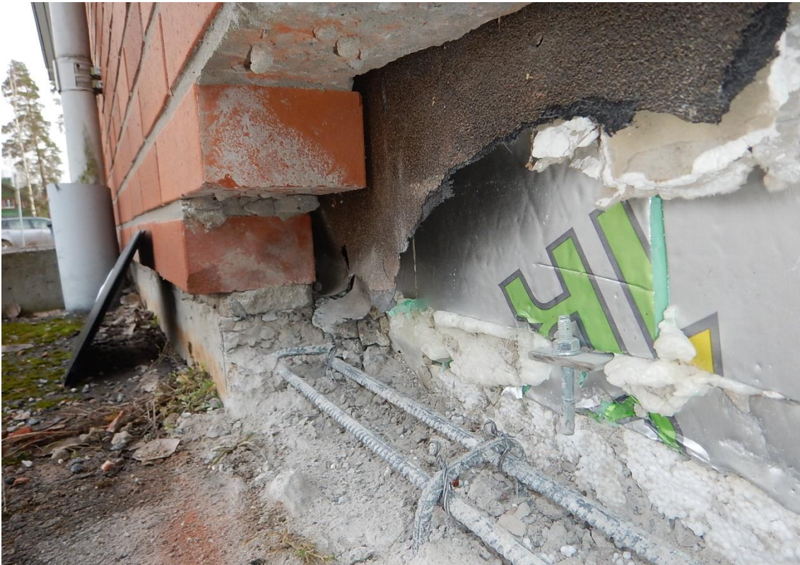
Kuva 23. Avaus SK102 keittiön kohdalla. Kuvassa näkyy vanhaa tuulensuojalevyä ja kermitystä, joiden takana uusittua rakennetta mm. Finnfoam PU-levy. Halkaisussa ei havaittu puumateriaaleja.
