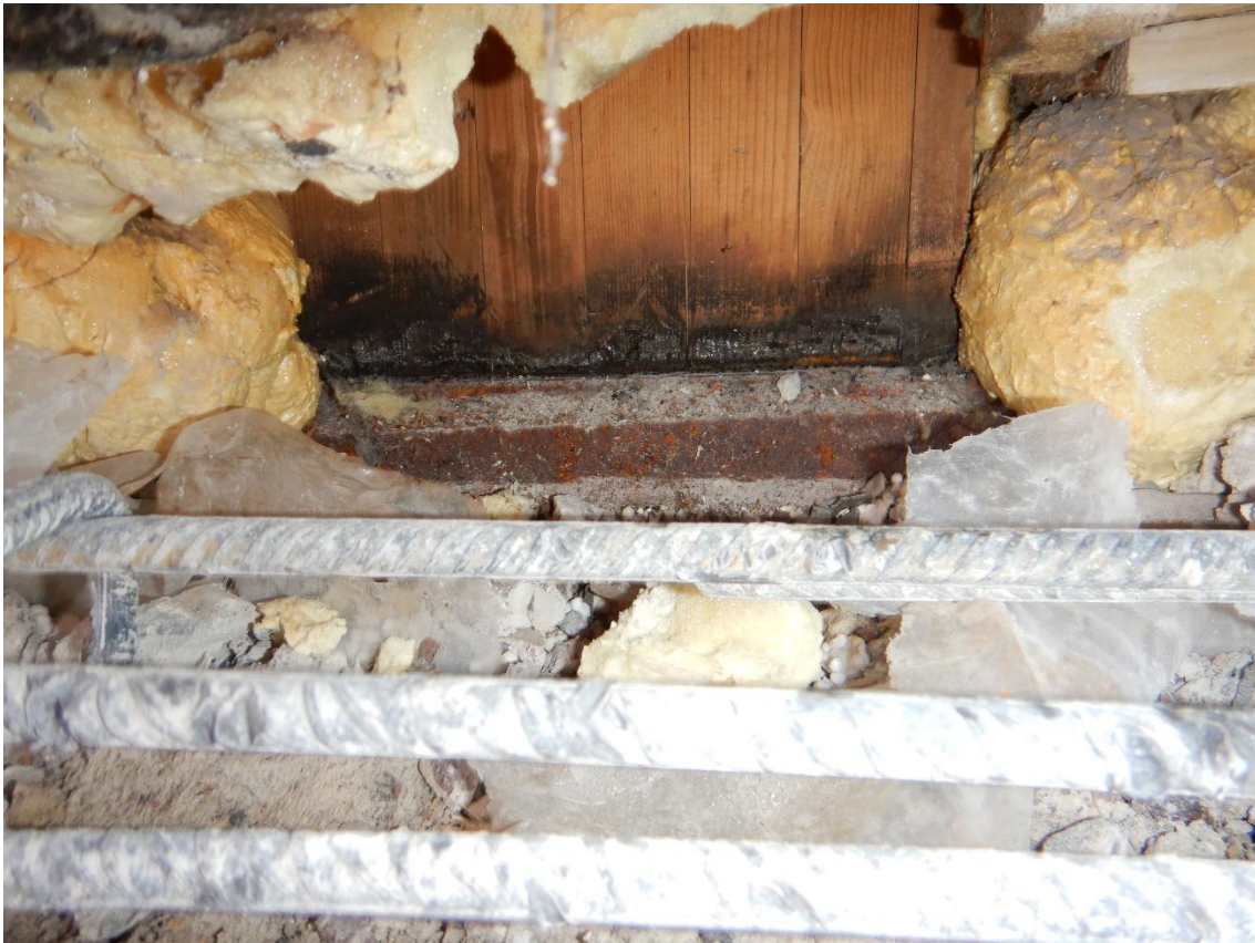
Kuva 47. Pilarin alareuna on käsitelty ja sen vuoksi tumma alareunastaan. Alueella oli terva- mainen tuoksu tai palaneen tuoksua.
