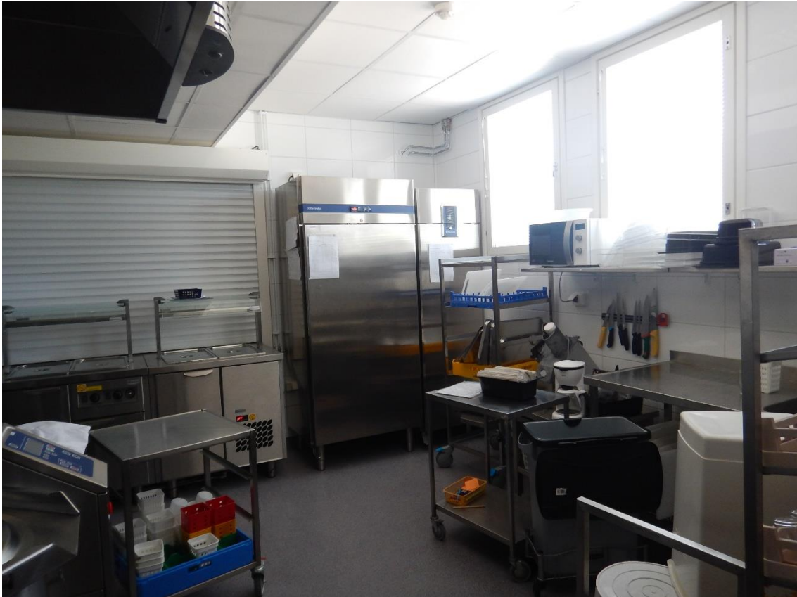
Kuva 99. Keittiötilat uusitut ja hyväkuntoiset.
