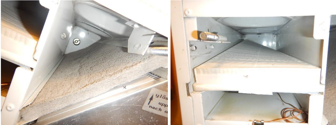
Kuva 107. Eskaritulojen oman ilmanvaihtokoneen karkeasuodatin tukossa tutkimusten aikaan ja pääsuodatin kiero jolloin ilmavirrat ohittavat suodatuksen.
