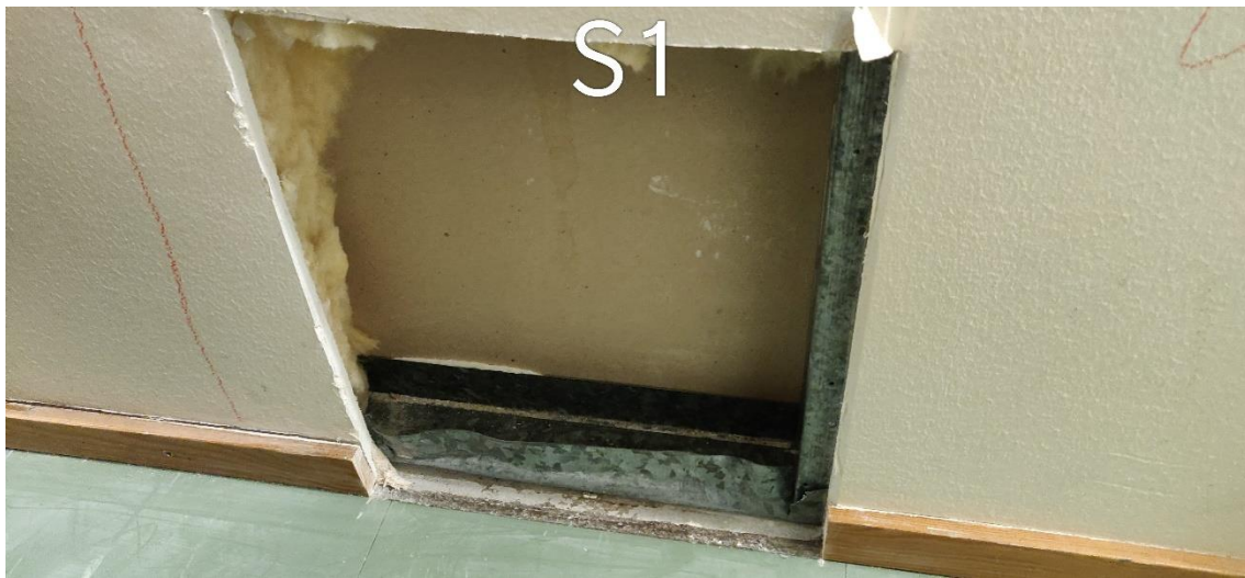
Kuva 82. Käytävän ja pukuhuoneiden välisessä seinässä metalliranka.
