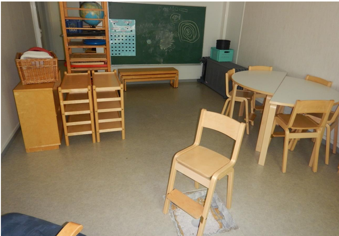
Kuva 36. Rakenneavaus A5 tilan T5 keskilattialle.
