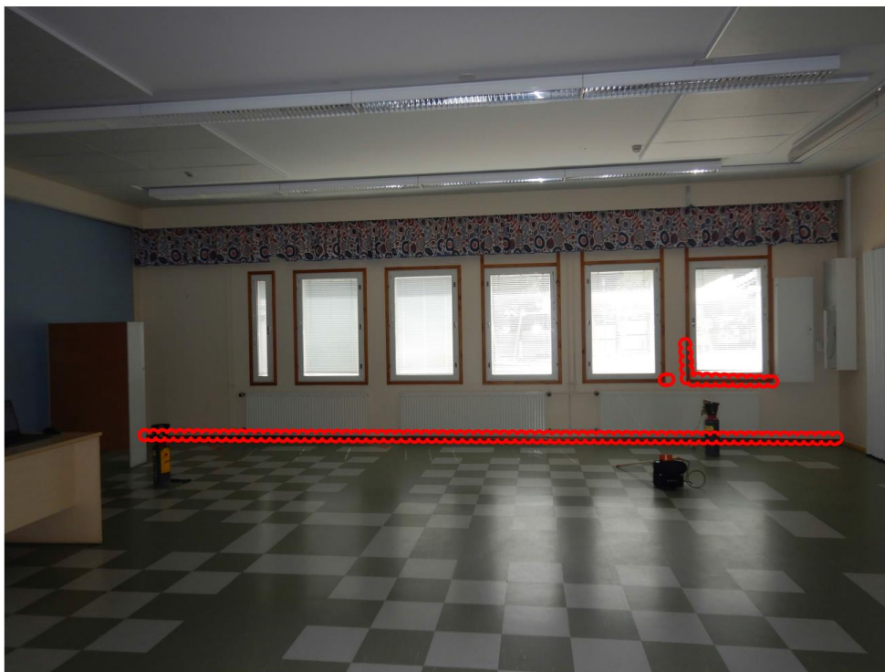
Kuva 120. Havaittuja ilmapuotokohtia Opetustilassa 175.
