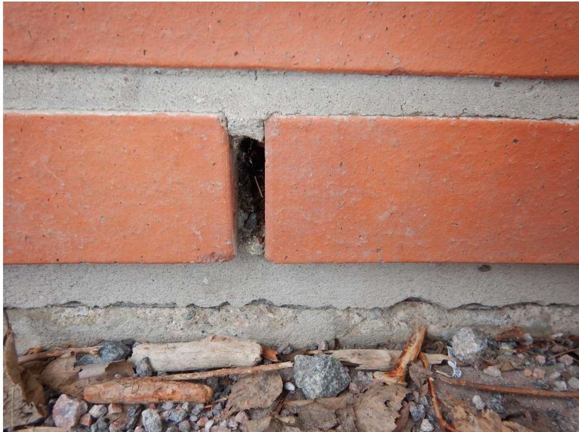
Kuva 20. Kuvassa näkyy ulkoseinärakenteen alareuna ja sokkelin yläreuna, joiden välissä on bitumikermi. Osassa rakennusta ulkoseinän alaosa on lähes samassa korossa maanpinnan kanssa.
