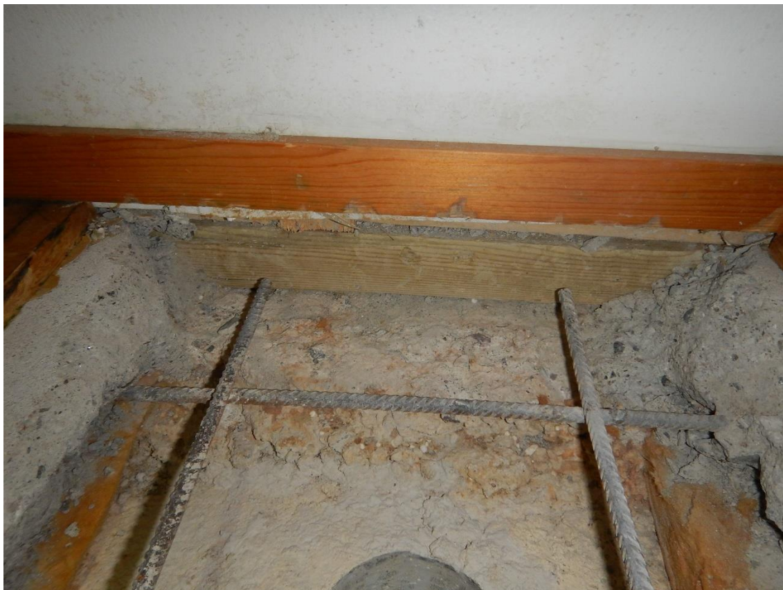
Kuva 45. Rakenneavaus S5 kantavan seinän alajuoksu painekyllästettyä puuta.
