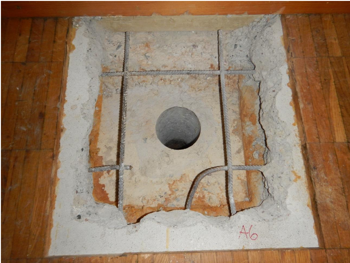
Kuva 32. Rakenneavaus A6 opettajan tilan lattiaan.
