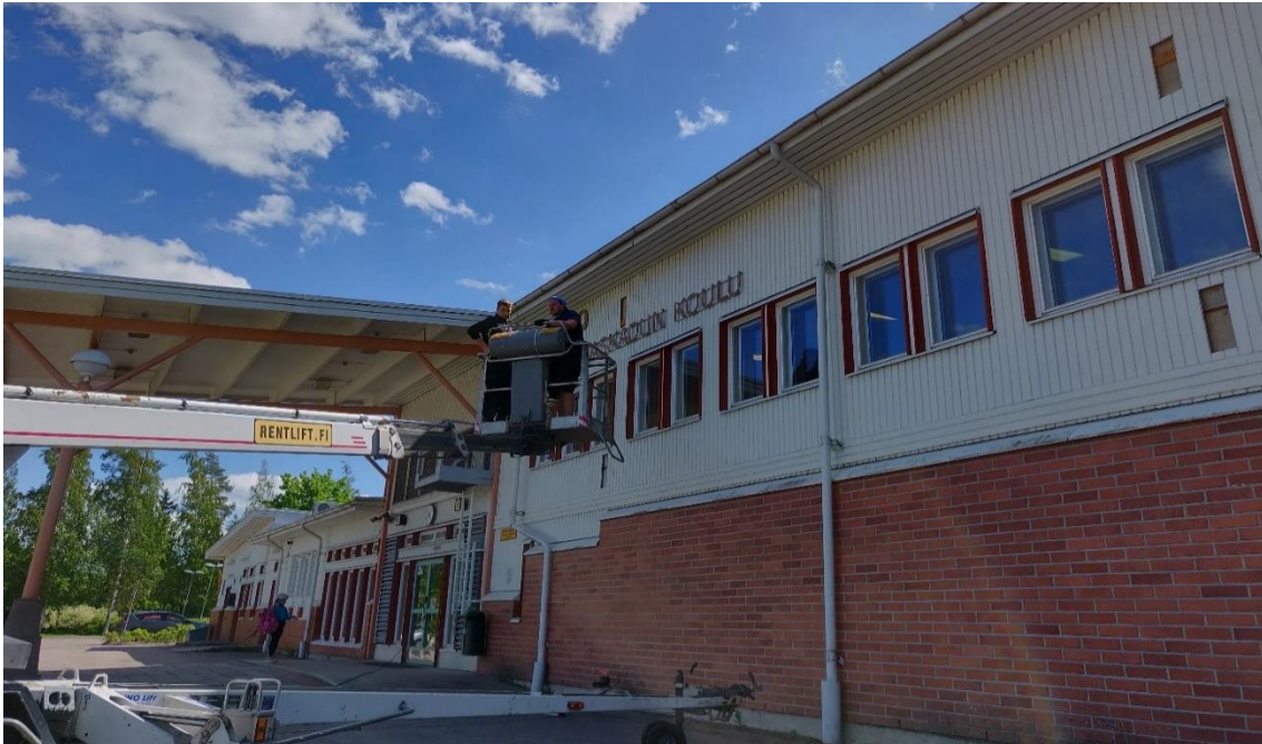
Kuva 54. Ulkoseinässä lautaverhouksen tuulettuvuus katkeaa vaakasuuntaisiin rimoihin.
