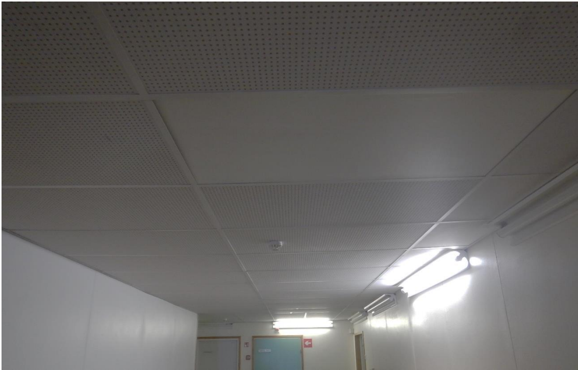
Kuva 91. Käytävien sisäkatot ovat rei'itettyä kipsiä. Levyt ovat hyväkuntoisia.
