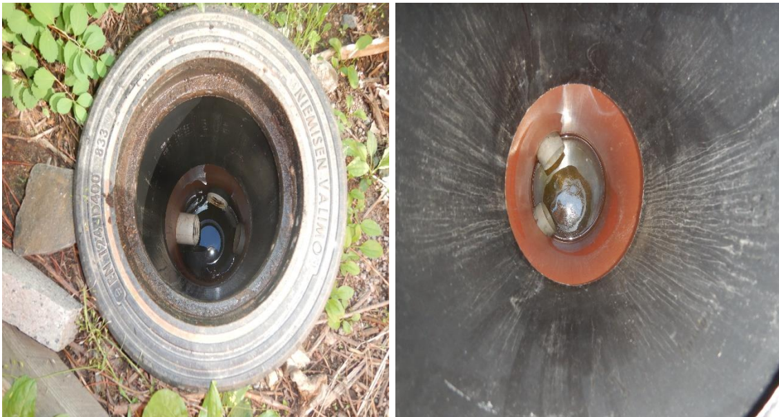
Kuva 5. Sisäpiha-alueen salaojakaivot pääosin siistissä kunnossa eikä merkkejä toimimattomuudesta.
