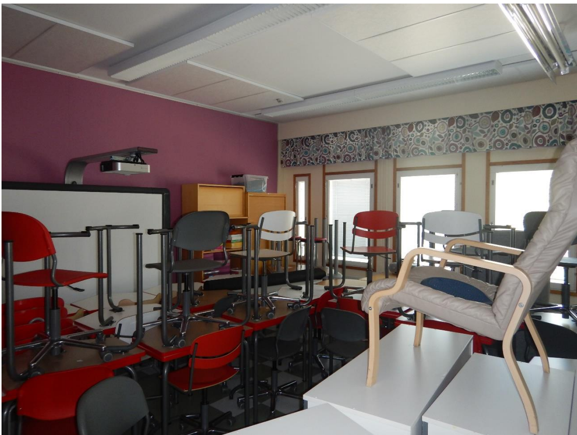
Kuva 90. Luokkatiloissa sisäkatot ovat hyväkuntoisia ja pääosin kipsiä, joissa on äänieristelevyjä liimattuna kattopintaa.
