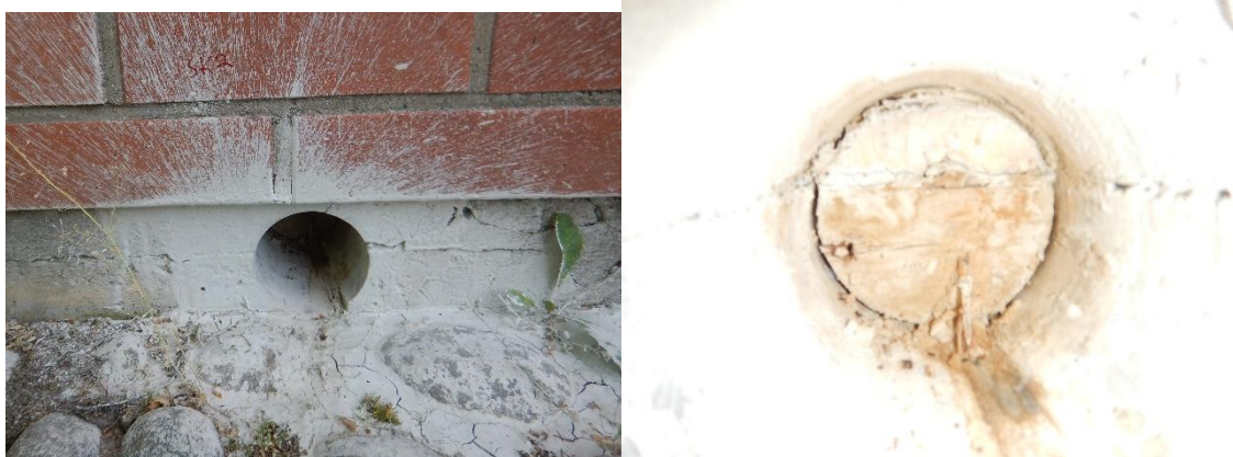
Kuva 21. Sokkelin eriste on tuettu valun ajaksi vanerinlevyn kappaleilla jotka ovat edelleen sokkelin sisällä. Ne ovat materiaalinäytteiden ja aistinvaraisten arvioiden perusteella huonokuntoisia.
